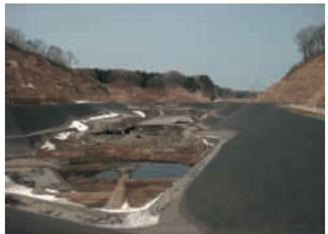
最終処分場現地確認
